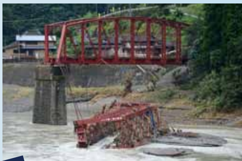
崩落した球磨川第一橋りょう
